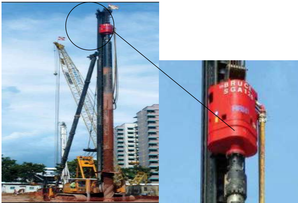
Рис. 2. Гидравлический вращатель BRUCE серии SGA
