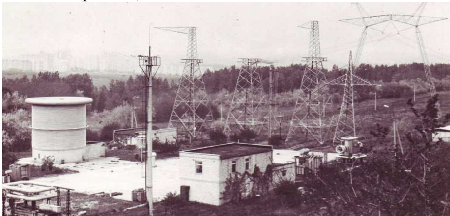
Рис. 10. Высоковольтный полигон: ГИН-2500 кВ, ИТ-500 кВ, две фазы УСВЛ-500 кВ на опоре ВЛ 750 кВ
